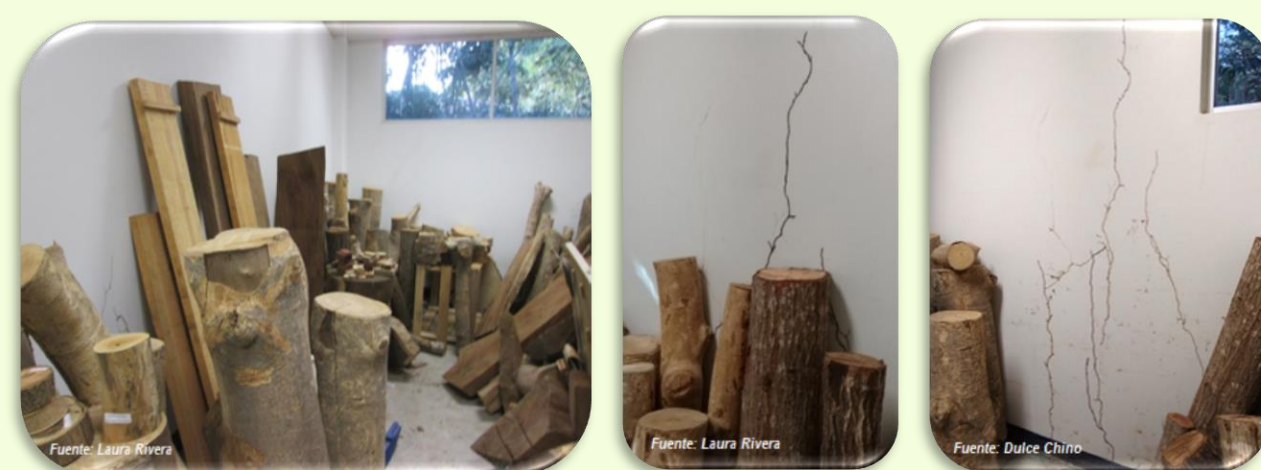
Vista general de algunas partes del área cerrada donde se encontraban las piezas de madera para su acondicionamiento.
